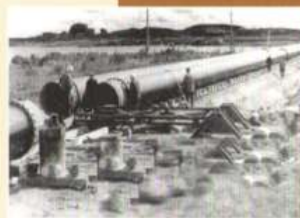
Труба водовода для питания ТЭЦ водой
