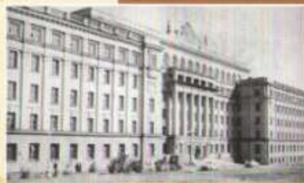
Новое здание горно-металлургического техникума. 1950-е годы
