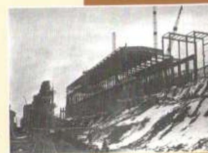
Строительство Большой обогатительной фабрики. 1948 год
