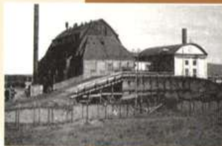
Временная электростанция в Норильске. 1940 год
